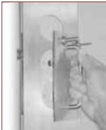
2. Colocar o padrão. Place the pattern.
